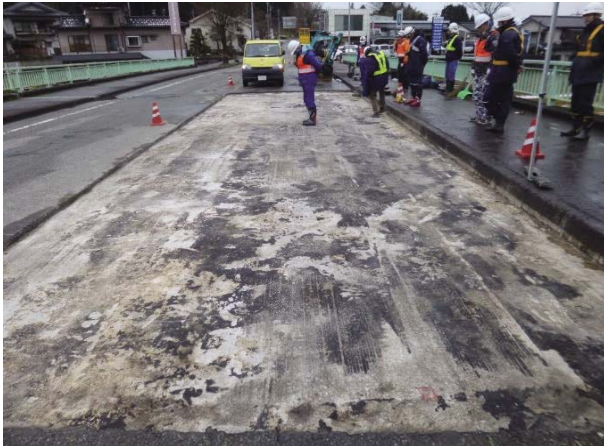
写真- 3.9 E 橋の床版上面損傷状況
