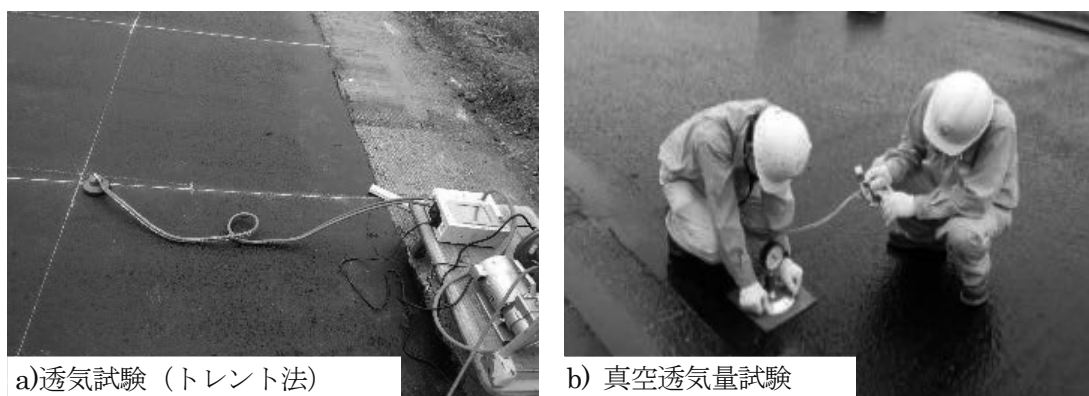
写真- 6.7 透気試験状況
