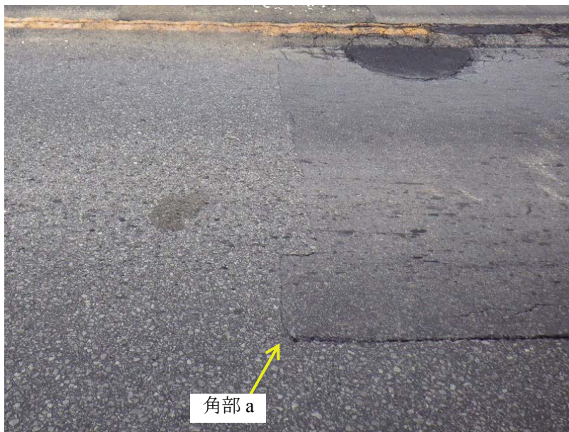
(a) 供用中の路面 As 舗装の状況
