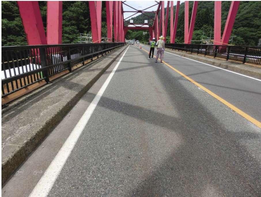
(a) 路面全体
