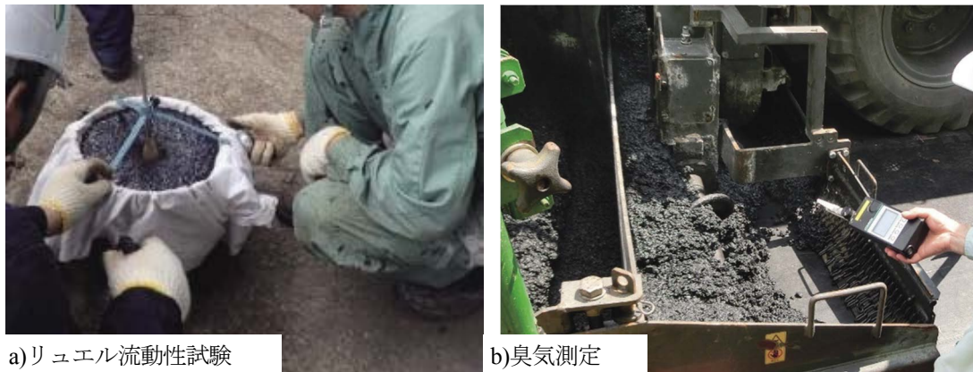
写真- 6.3 施工時材料性状確認状況
