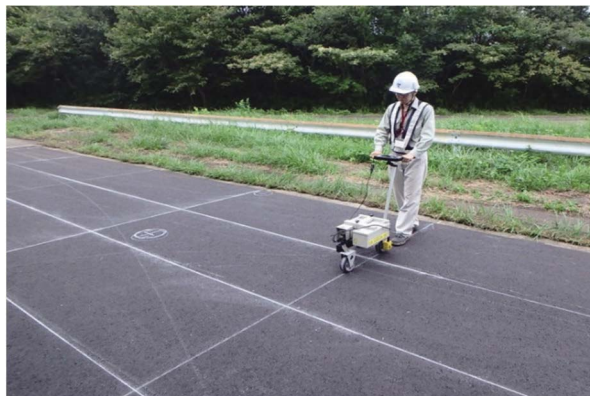
写真- 6.9 わだち掘れ量測定状況
