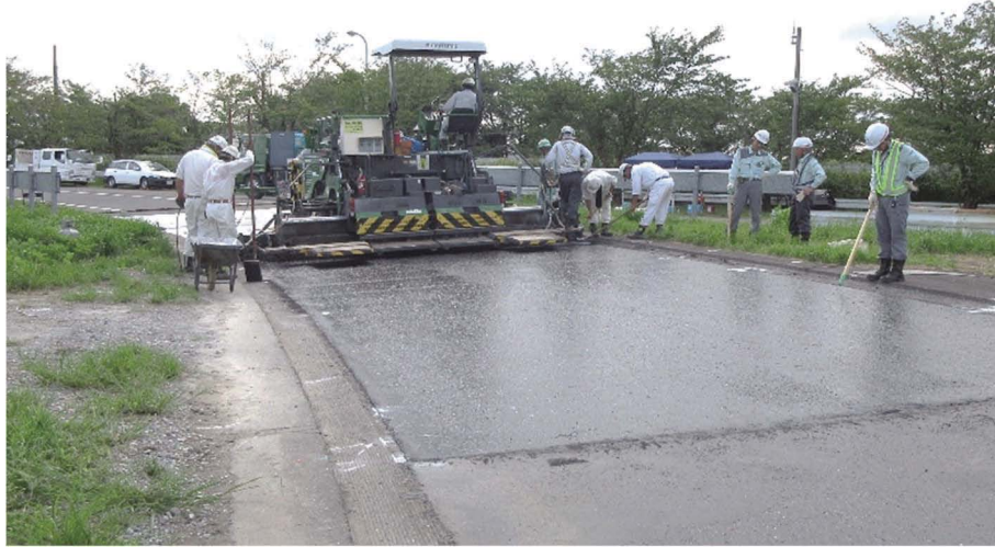
写真-6.4 開発グース施工状況
