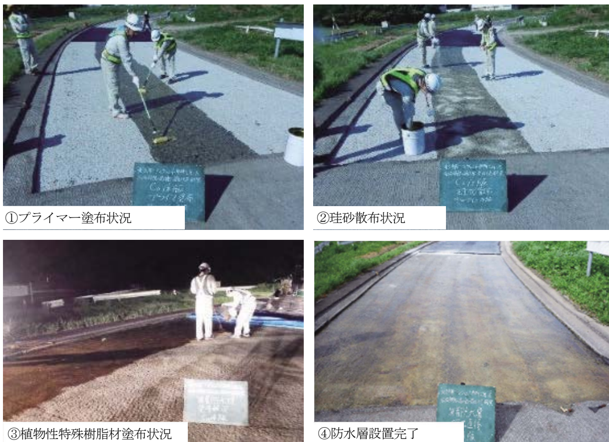
写真- 6.6 樹脂充填混合物施工状況
