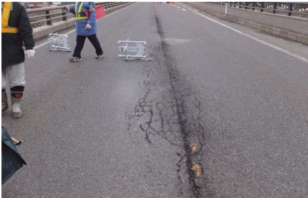
(b) 舗装を剥がす直前の状況
