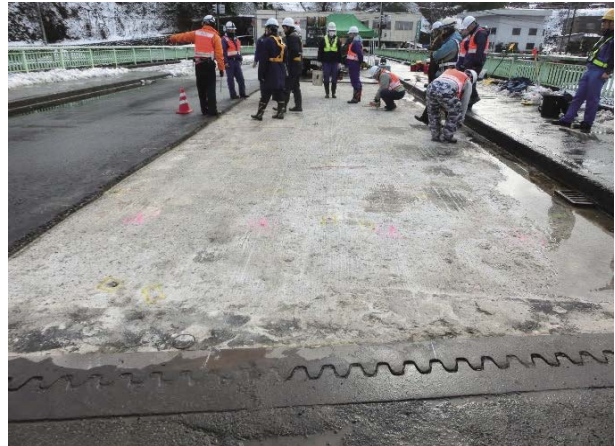
写真- 3.9 E 橋の床版上面損傷状況
