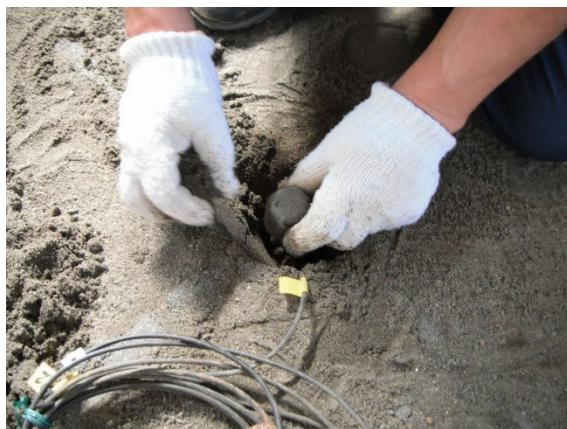
(a) 間隙水圧計設置作業
