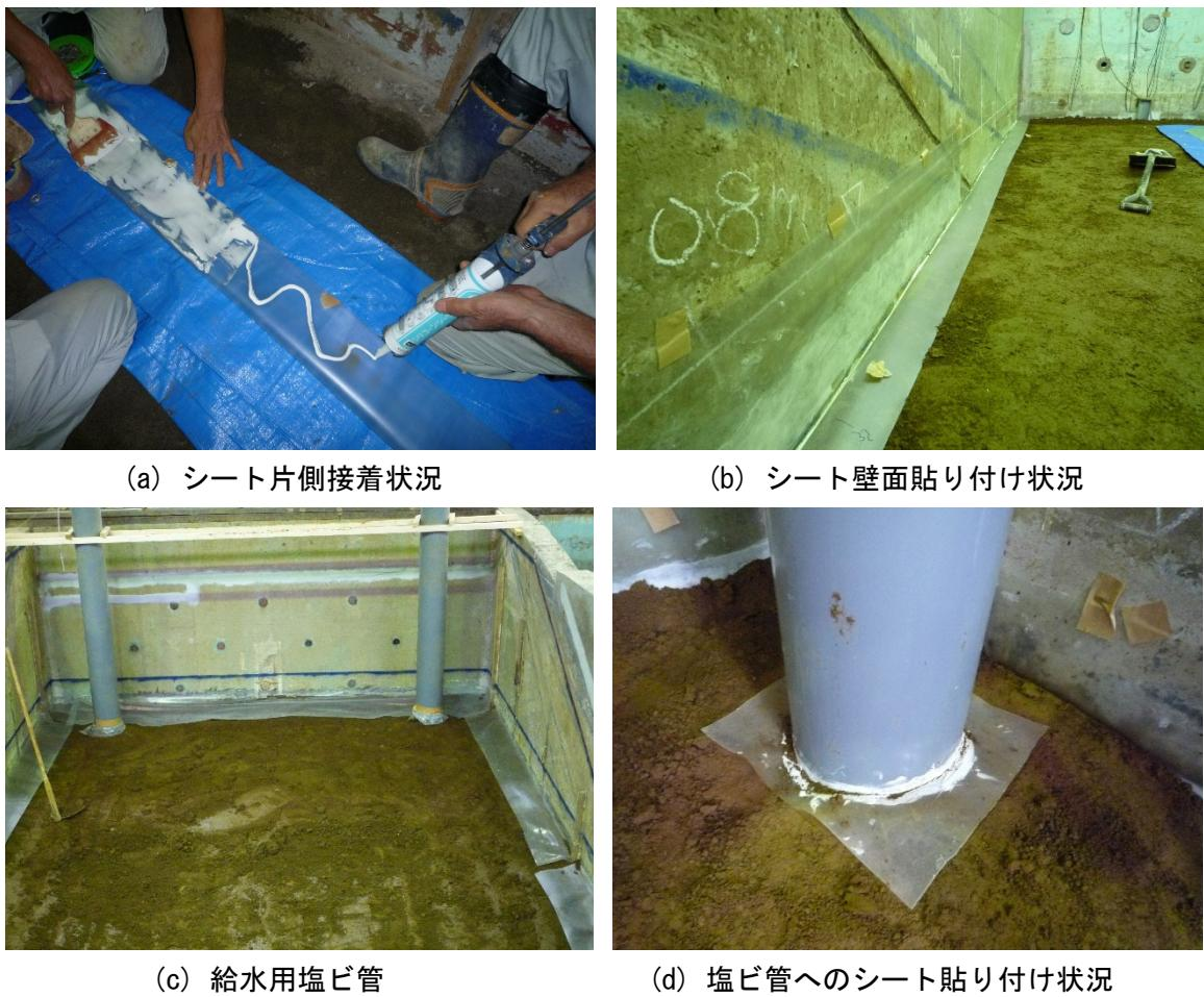
図 2-7 漏水防止対策
