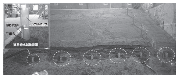
図 5 簡易透水試験実施状況
