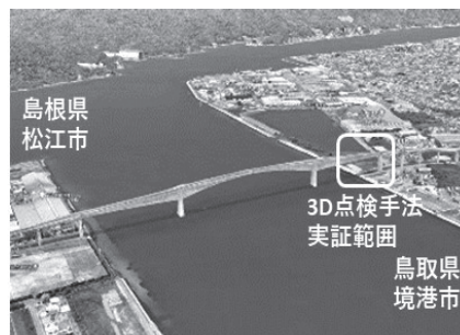
図-1：大規模橋梁の例：江島大橋
